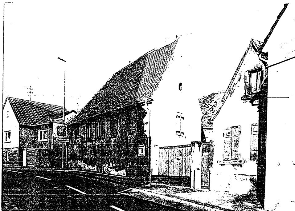
Erhaltenswerte historische Bausubstanz
